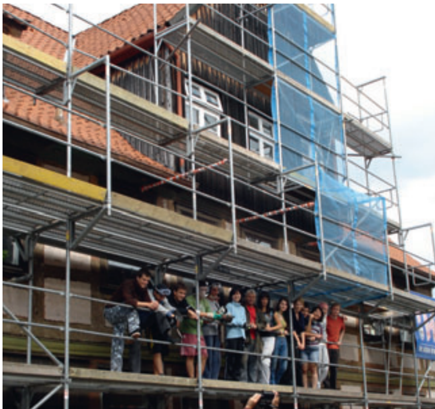
Workcamp-Gruppe bei der Sanierung der Fassade
