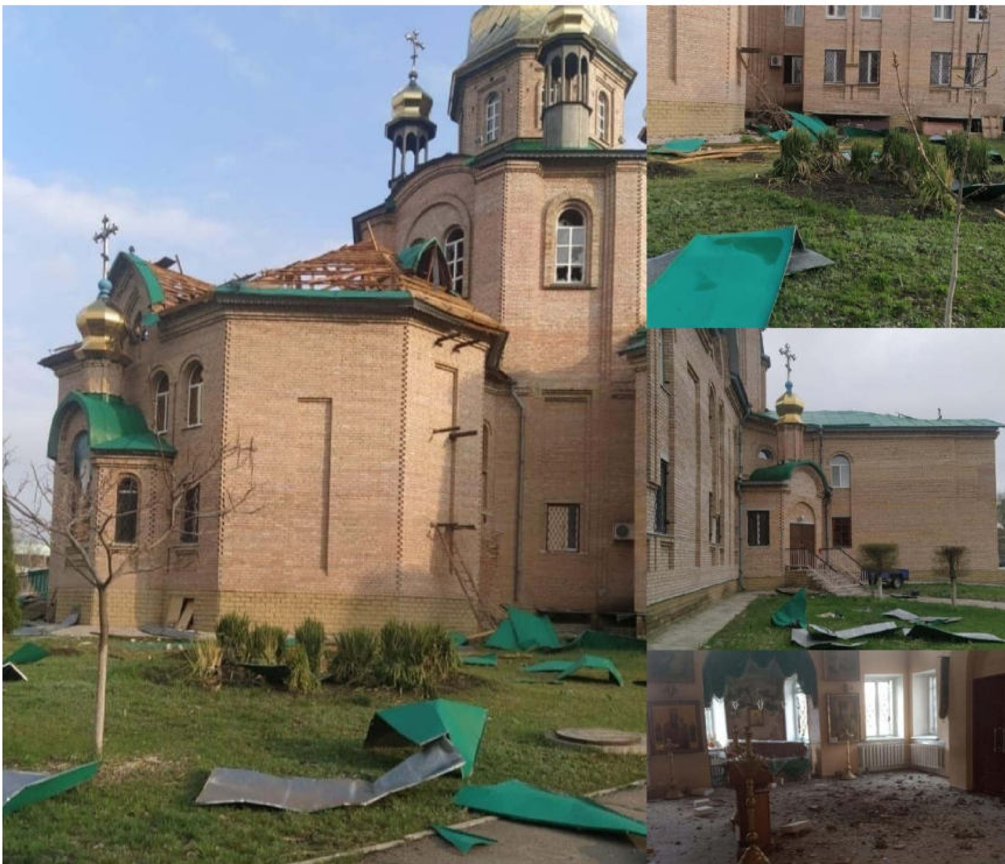
Наслідки артобстрілу будівлі собору в Сєвєродонецьку (Луганська обл.), фото: Сергій Гайдай, 17.04.22
