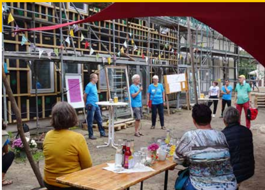
Tag der offenen Tür mit Rundgängen über die Baustelle unseres neuen Tagungshauses, was 2022 eröffnet werden wird.
