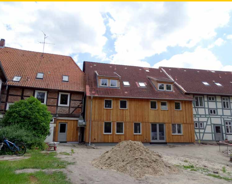
Unsere Seminargäste werden seit diesem Jahr nicht mehr im alten Haus in der Kirchstr. 14 empfangen, sondern in den zwei frisch sanierten Häusern Nr. 16 und 18.
